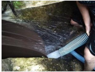
Gambar 15 Penyaluran Air ke Turbin Selang 3 inch
