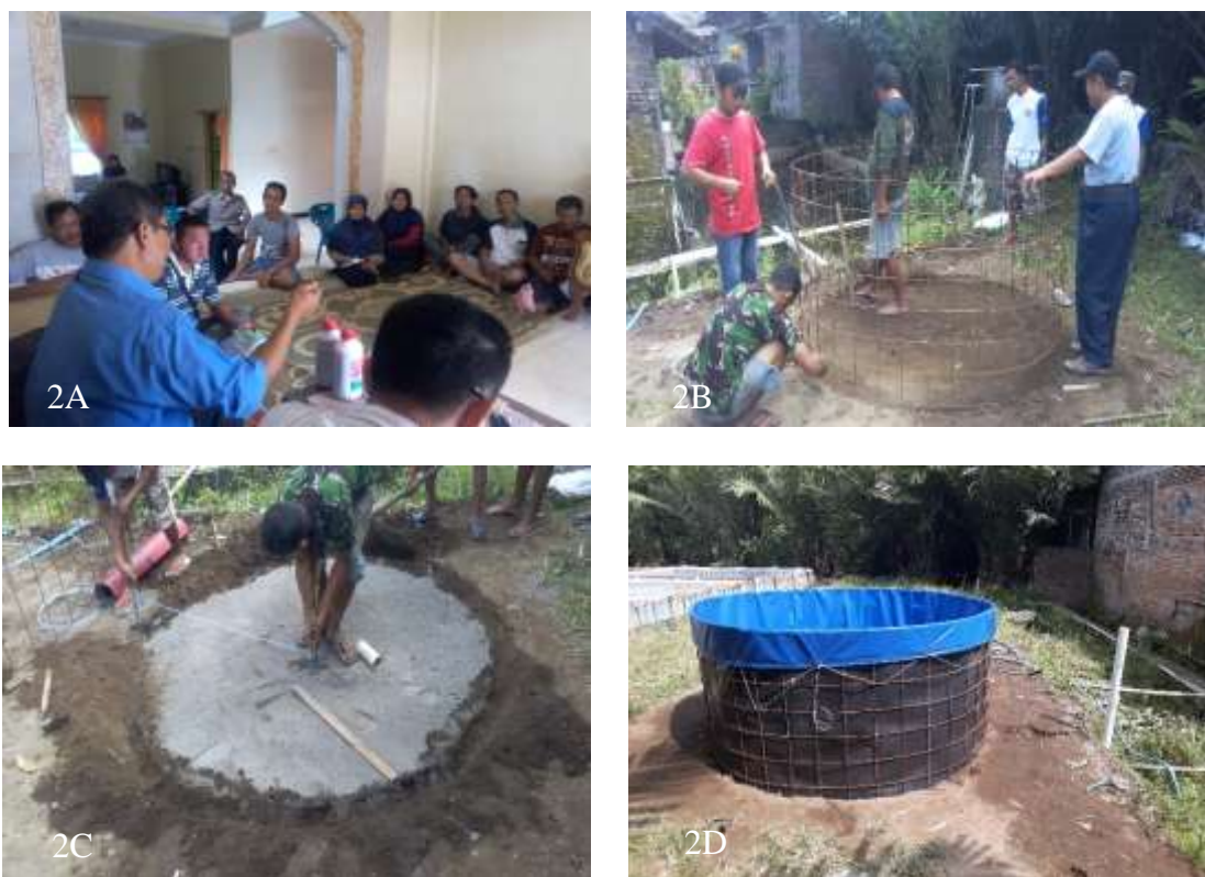
Gambar 2. Kegiatan penyuluhan dan pelatihan budidaya ikan, 2A: penyuluhan budidaya ikan, 2B dan 2C: pembuatan kolam terpal, 2D: kolam terpal yang sudah jadi dan siap digunakan.
