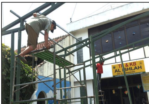
(a) Pemasangan rangka atap
