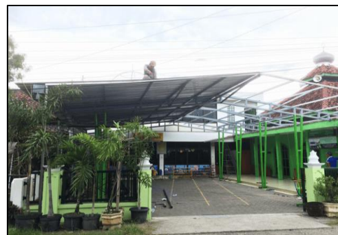
(b) Pemasangan penutup atap
